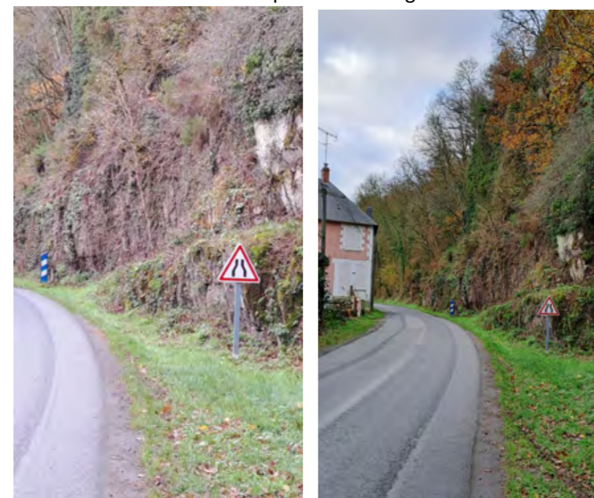
Le Moulin Rose : Pose de panneaux de signalisation
