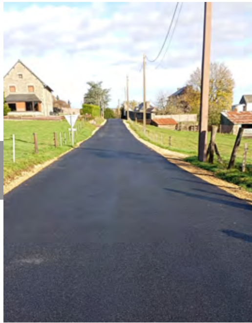
BANDE DE ROULEMENT RUE DE L'ANCIEN PRESBYTÈRE
