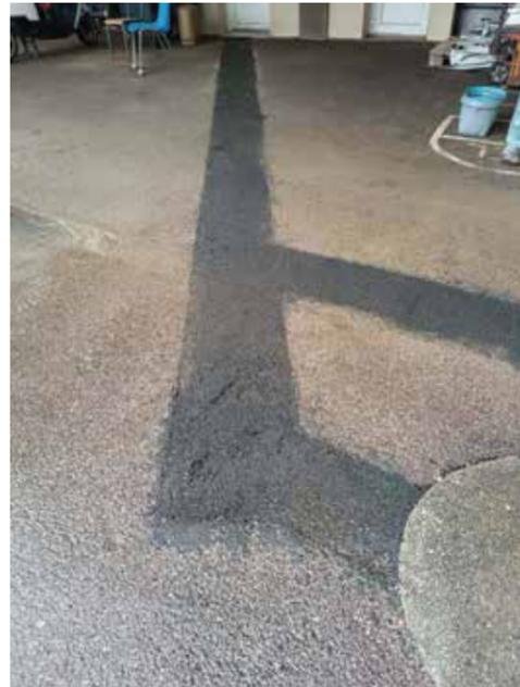
Raccordement de l'évacuation de l'ancienne cuisine à la fosse toutes eaux. Elle était jusqu'à présent branchée sur le réseau pluvial.
