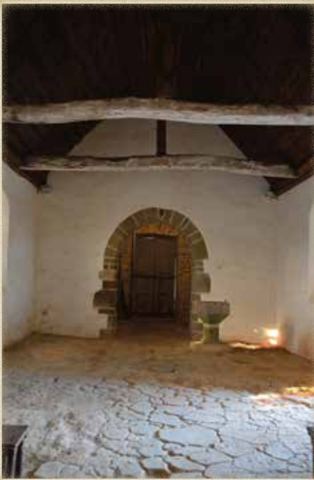
Décapage de la chaux et de l'aubier mûr suivi d'un traitement puis une application de cire teintée sur les poutres
