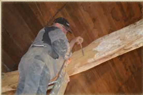
Décapage de la chaux et de l'aubier mûr suivi d'un traitement puis une application de cire teintée sur les poutres
