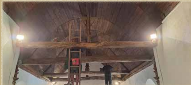
Décapage de la chaux et de l'aubier mûr suivi d'un traitement puis une application de cire teintée sur les poutres
