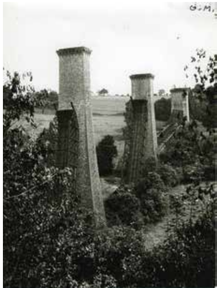
La destruction de la voie ferrée
