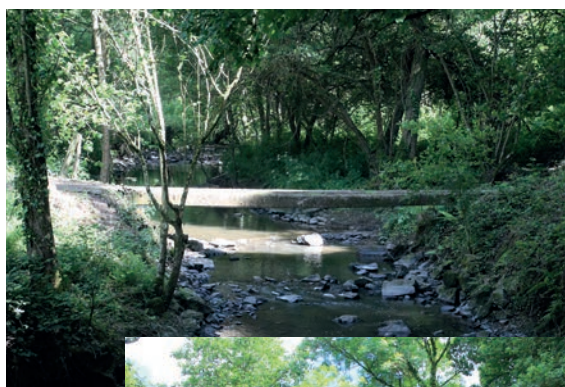
Pont de l'escarbot - Avant
