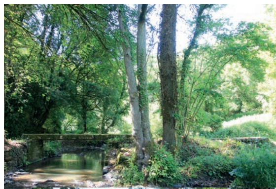
Le moulin de feuillet - Avant
