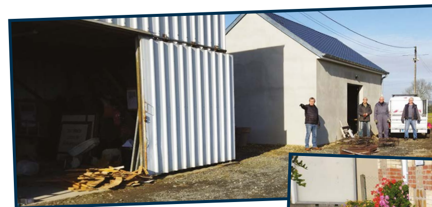
AMÉNAGEMENT DANS LE NOUVEAU LOCAL DE STOCKAGE
