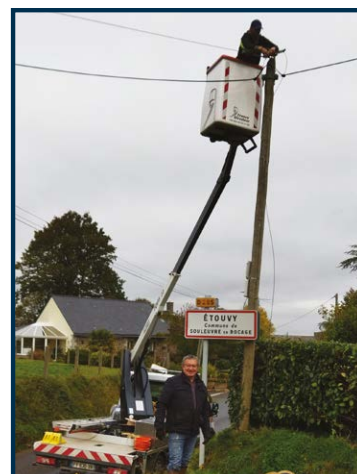
POSE DE LA FIBRE
