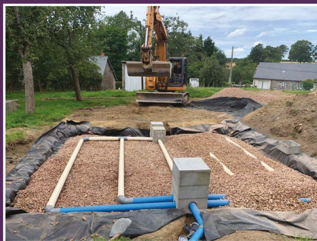
Travaux d'assainissement au logement communal du Hameau Mulot
