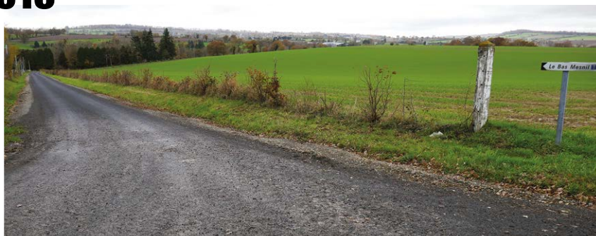
La réfection du revêtement du chemin du Bas Mesnil
