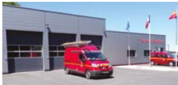
La nouvelle caserne de Bény-Bocage
