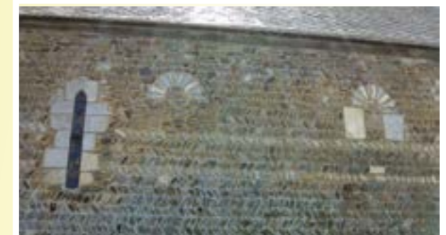
Détail de l'appareil du mur nord de l'église avec l'emplacement des fenêtres anciennes
