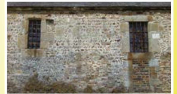
L'emplacement de la porte primitive entre les deux fenêtres se reconnaît à la rupture de l'opus spicatum
