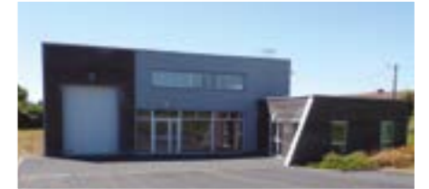
La nouvelle caserne de St-Martin des Besaces dont les travaux d'aménagement débuteront en juillet
