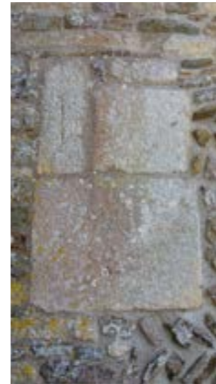
Chaînage d'angle en calcaire coquillier
