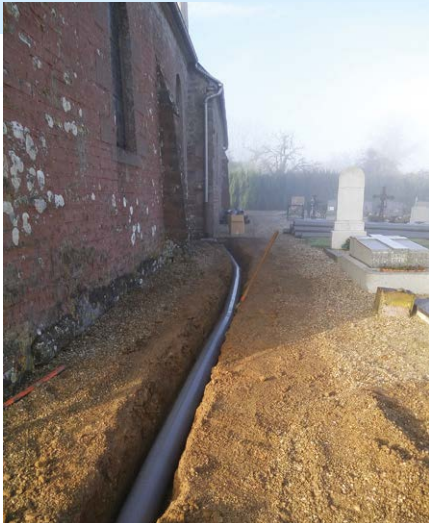
Busage des gouttières de l'église en février
