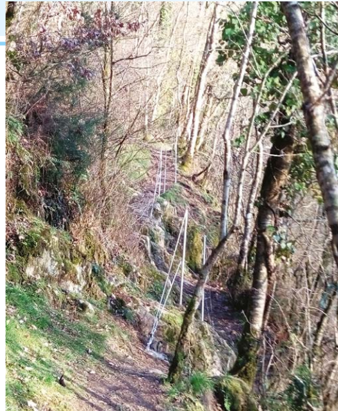
Sécurisation du chemin de randonnée le long de la Vire
